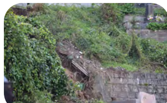
※中央墓地でも法面が崩壊し、墓石に土砂が流れ込みました。
