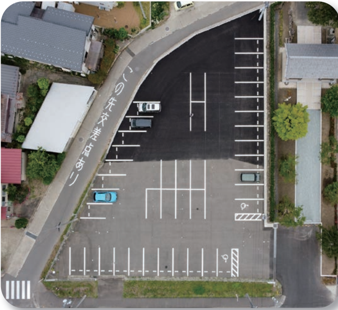
東駐車場全景
